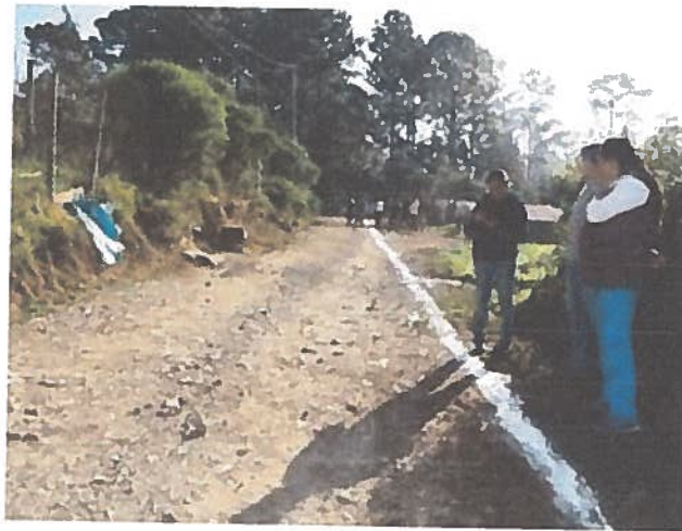
Fotografía 1.- Vista del lugar de los trabajos
